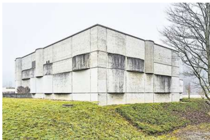
Das Grundwasserpumpwerk Thorenberg.
